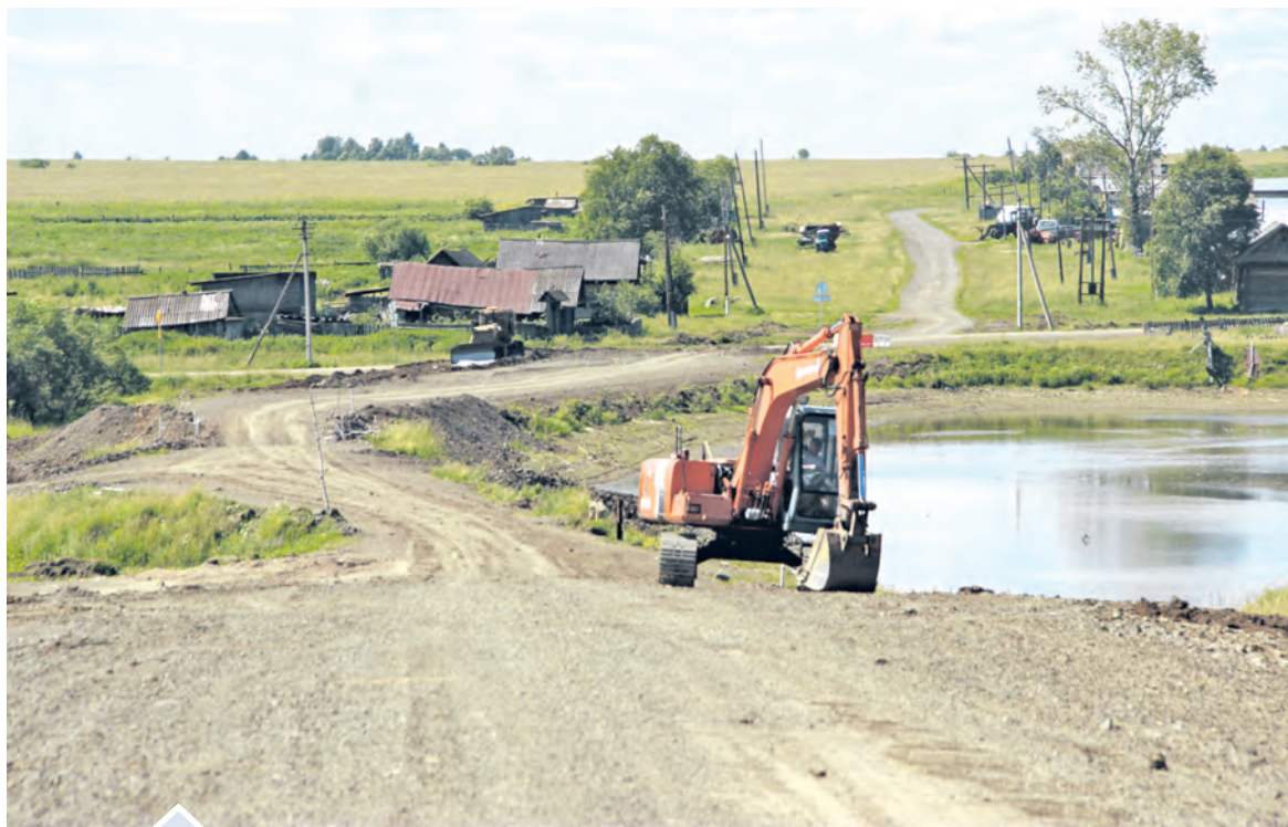
Идет начальный этап работ по реконструкции дорожного полотна
