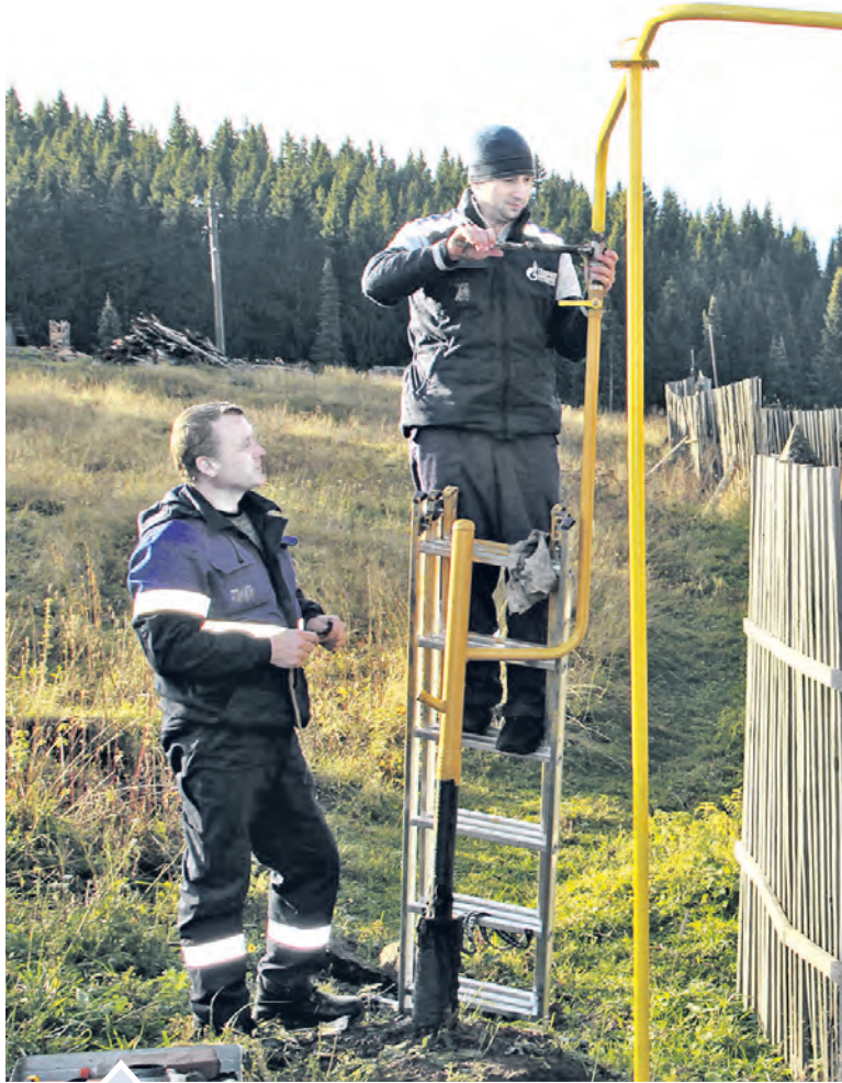
В среду газовой подключили к голубому топливу дом № 58 на ул. Степана Разина
