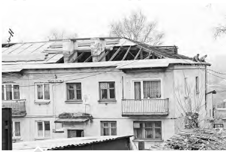
Скоро дом № 17 на ул. Свердлова обретет новую крышу
