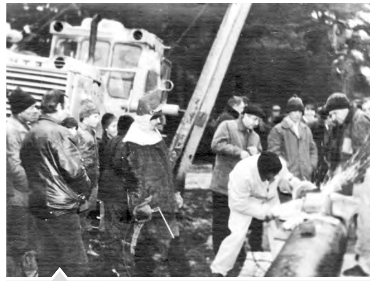
Укладка газопровода. Первый стык
