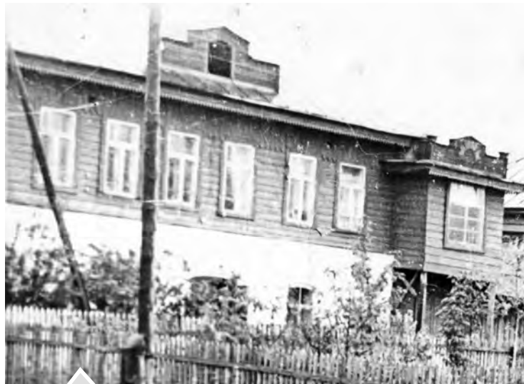
В этом доме проживали землеустроители. Фото начала 60-х годов XX века
