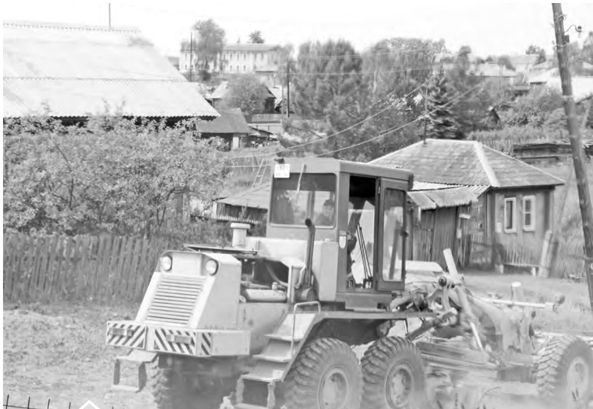
В рамках ремонта щебеночных дорог в железнодорожном микрорайоне идет грейдирование
